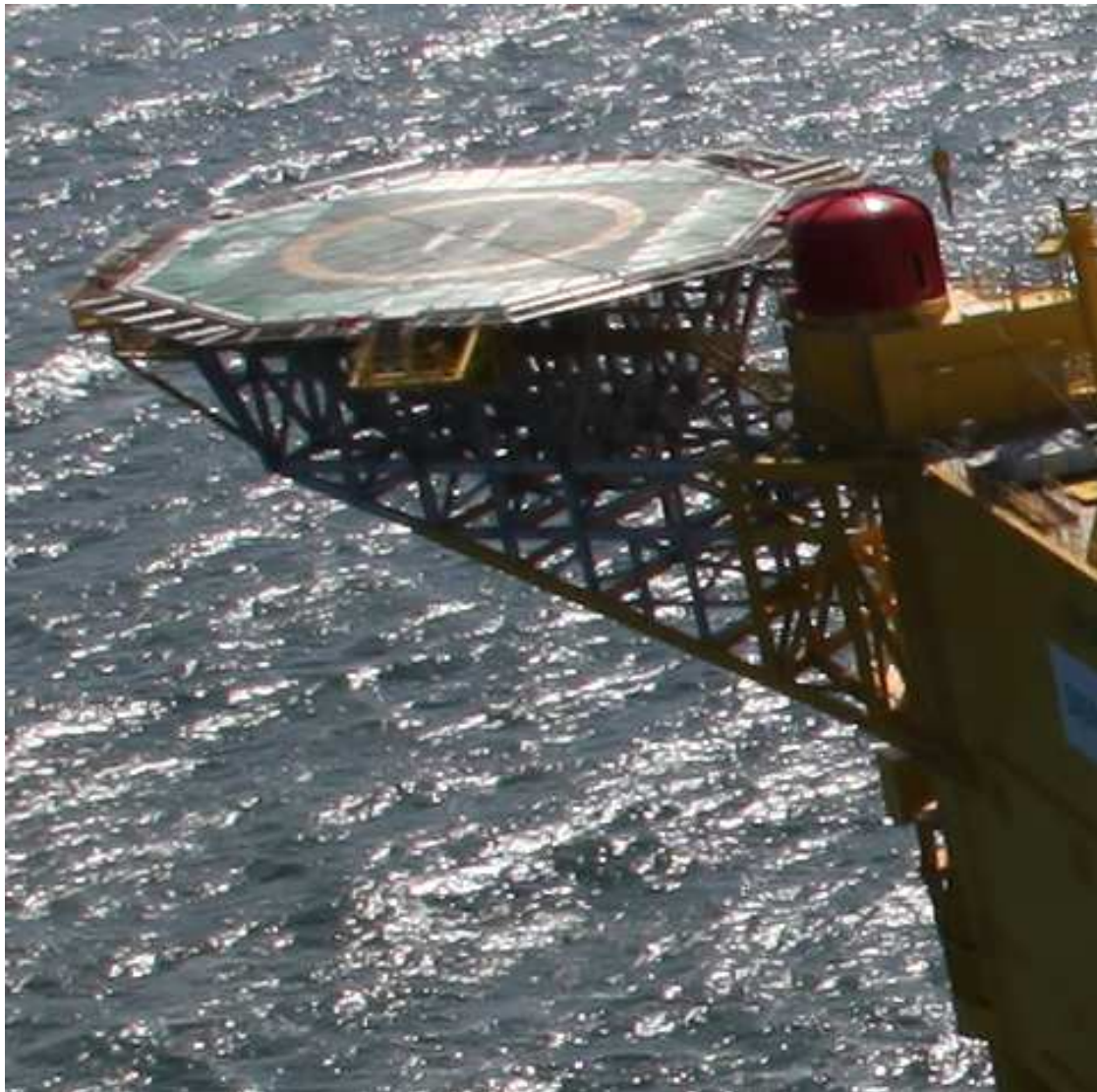
Abbildung 17: Helideck der HelWin alpha Offshore-Station (Quelle: TenneT TSO GmbH)
