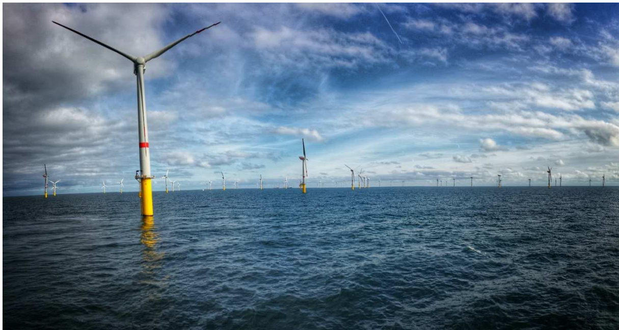
Abbildung 3: Blick in den Offshore-Windpark Global Tech I in der deutschen AWZ (Quelle: TÜV Rheinland Industrie Service GmbH)
