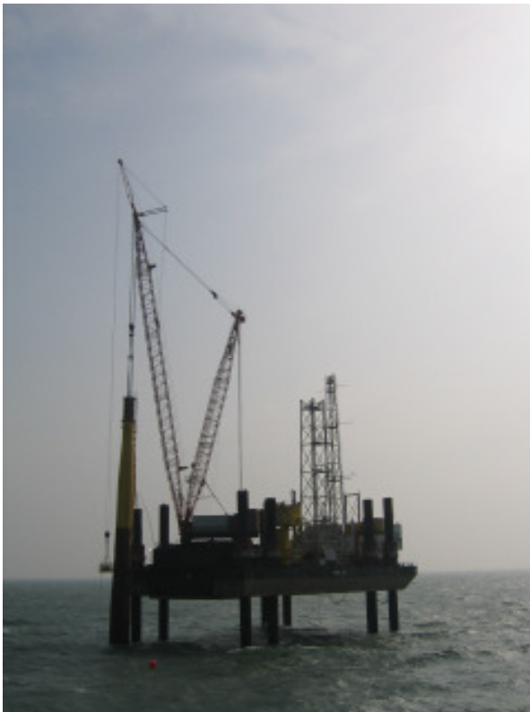
Pfahlrammung Amrumbank-West
